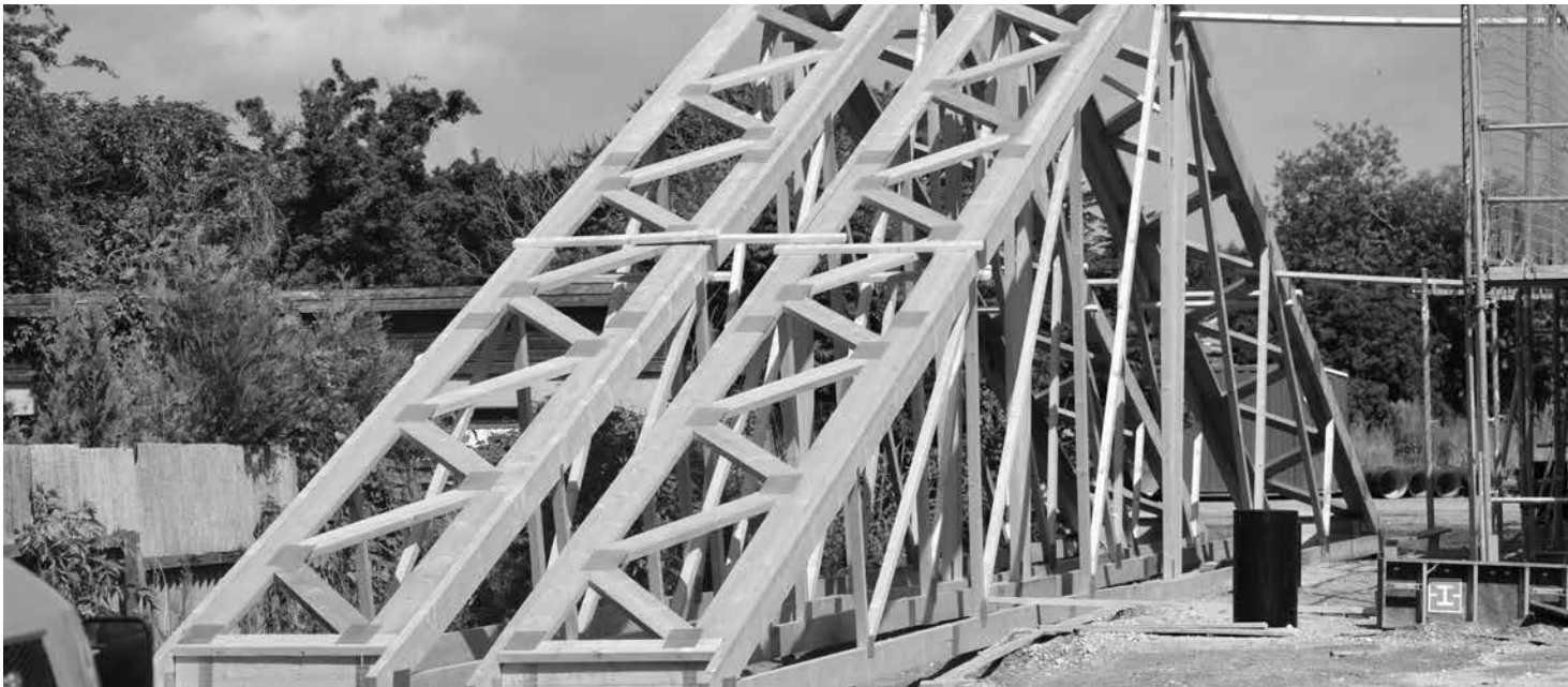
Holzträger für Hallendach
